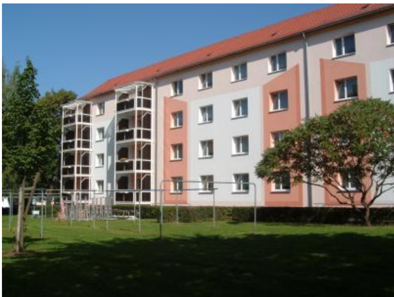
Beginn der nachträglichen Balkonanbauten ohne Austrittsschwelle am 1. Hauseingang des Gebäudes Apolda, R.-Breitscheid-Straße 8 -12
